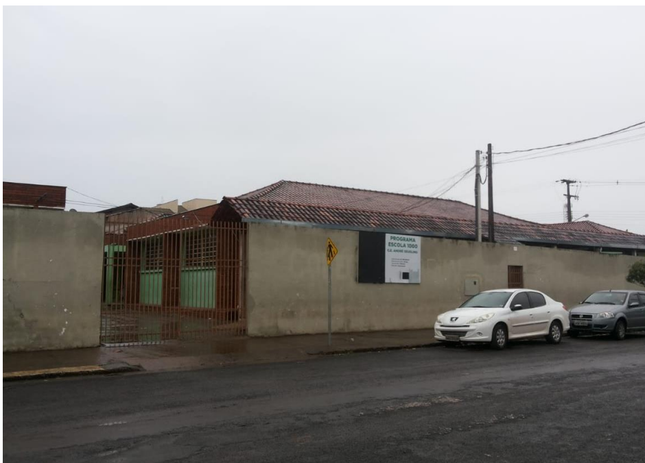
Figura 01: Vista da área Frontal do Colégio Fonte: LIMA, C. A (2018)
